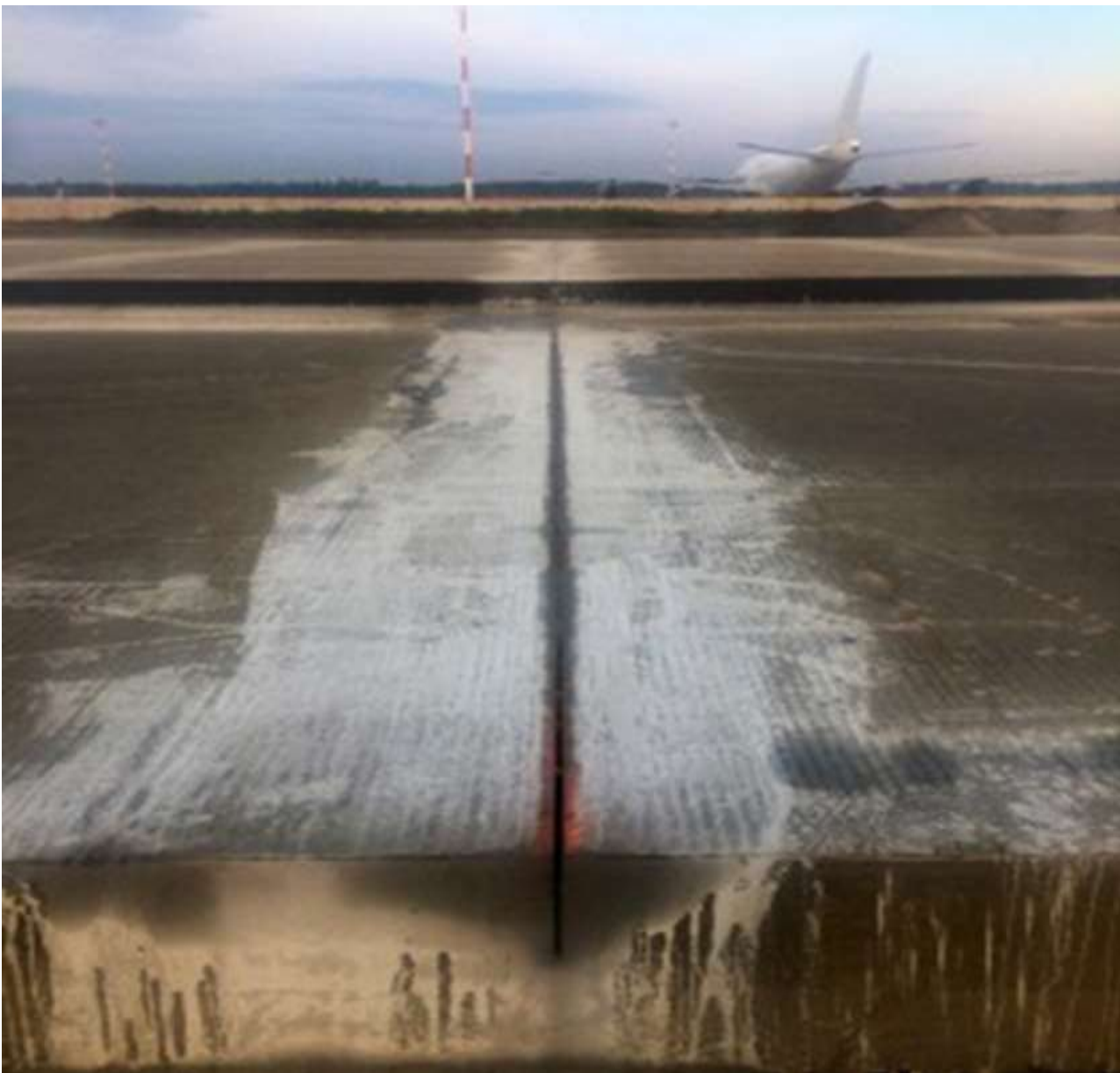
Фото 1 – пионерный шов Фото 2- Шов сжатия (технологический шов)
