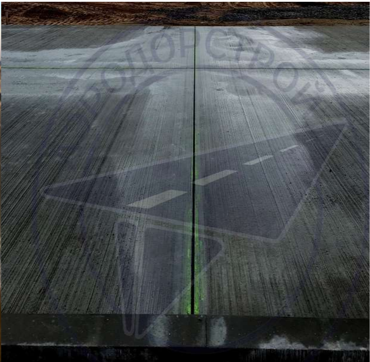
Фото 1 – пионерный шов Фото 2- Шов сжатия (технологический шов)
